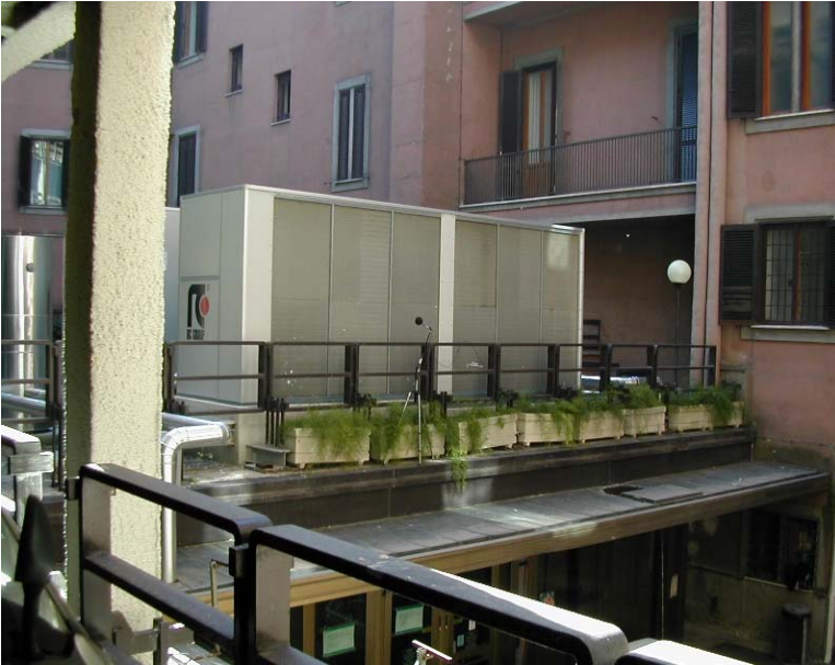
MISURE FONOMETRICHE IN CLASSE 1 SU MACCHINE CDZ
